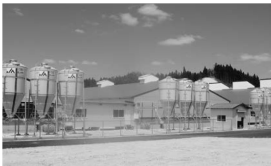
飼料タンク 畜舎用消臭BOX (屋上設置型)
