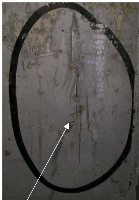
縦方向に発生した亀裂
