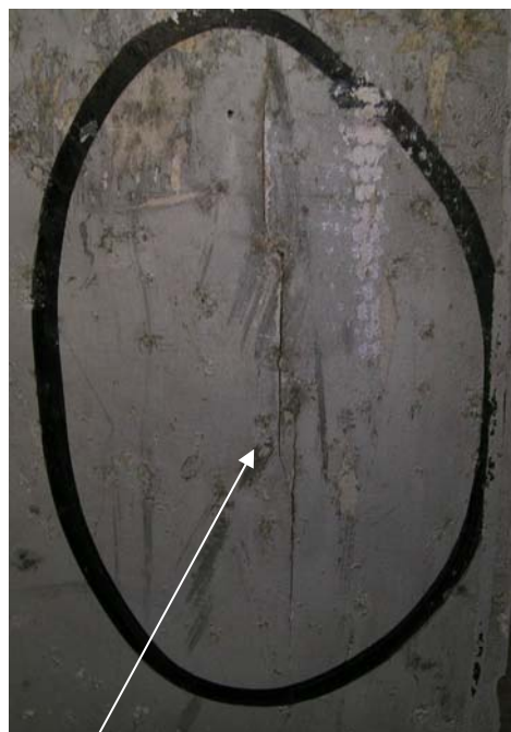
縦方向に発生した亀裂
