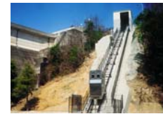
作業用昇降設備
